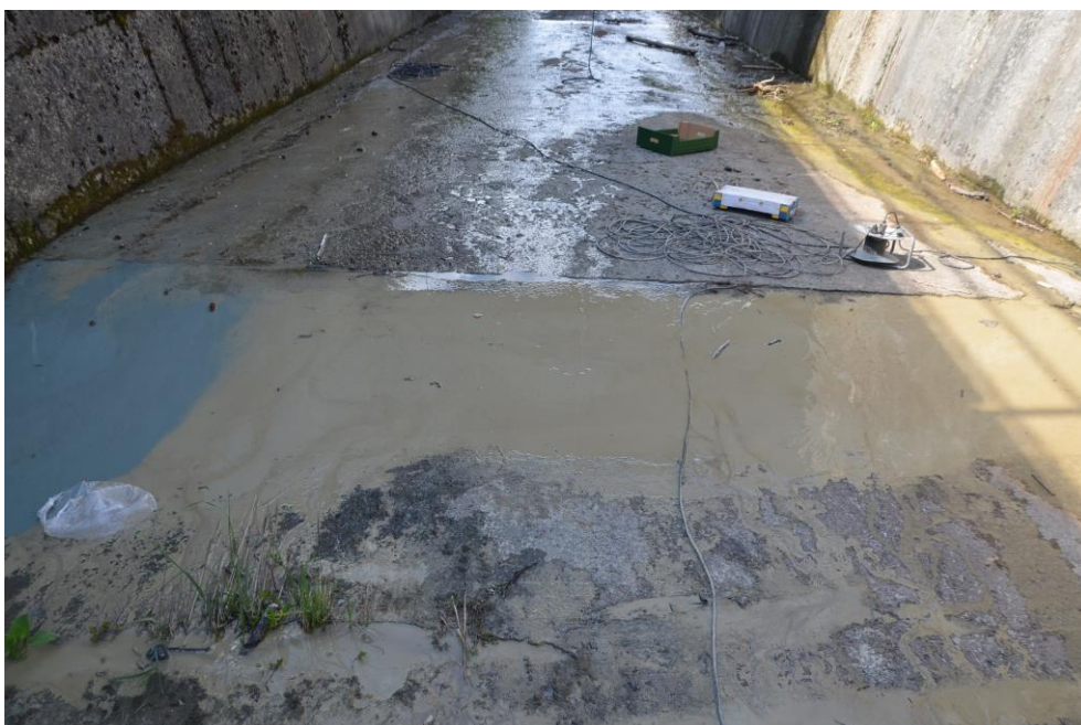
Obr.G99-32 Dno spadiště/skluzu. Pohled přibližně od konce přelivné hrany, přibližně ve směru staničení (po vodě), - v popředí výraznější nerovnost (prohlubeň).
