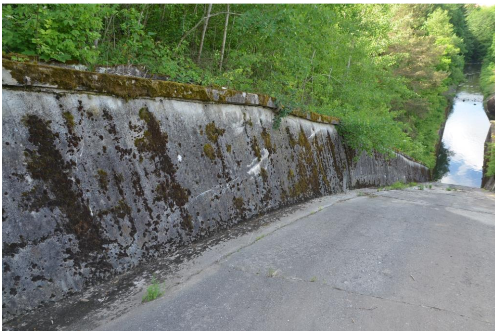
Obr.G99-16 Část levobřežní zdi skluzu za změnou podélného sklonu dna. Pohled zprava doleva a ve směru staničení (po vodě),
