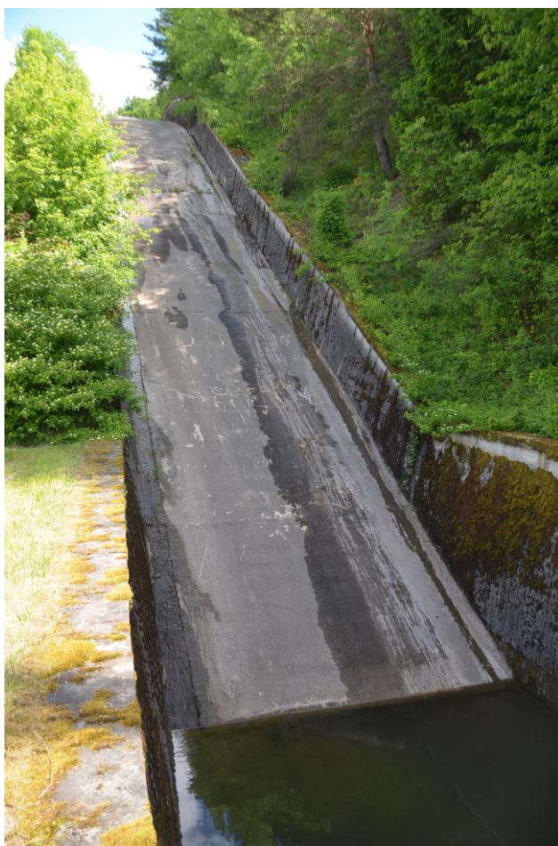
Obr.G99-04 Celkový pohled na konec skluzu navazujícího na bezpečnostní přeliv a spadiště. Pohled proti směru staničení (proti vodě) a zprava doleva, - vlevo je pravobřežní zeď skluzu, vpravo je levobřežní zeď skluzu.
