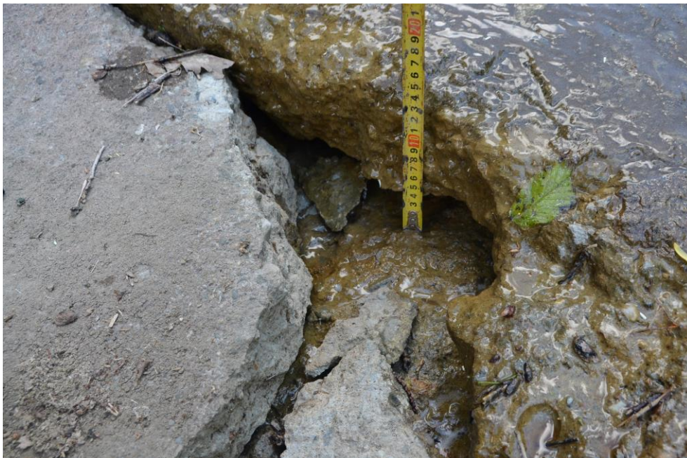
Obr.G99-45 Detail poruchy dna skluzu v místě změny podélného sklonu. Pohled zleva doprava, proti směru staničení (proti vodě) a dolů,
