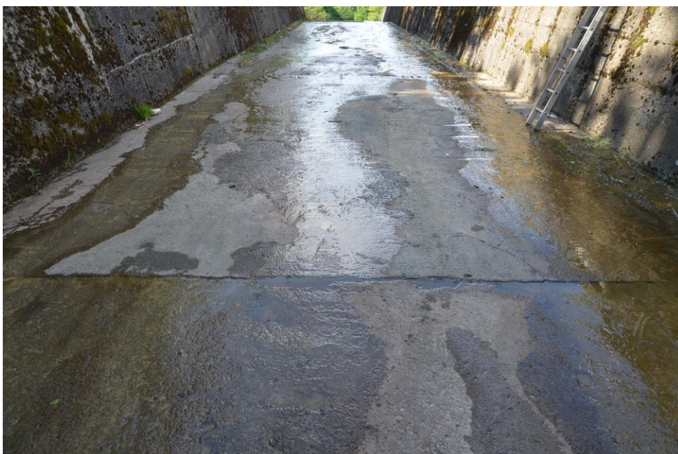
Obr.G99-38 Dno skluzu před změnou podélného sklonu. Pohled přibližně ve směru staničení a dolů (po vodě), - dno je nerovné, prohlubeň v místě příčné pracovní spáry.
