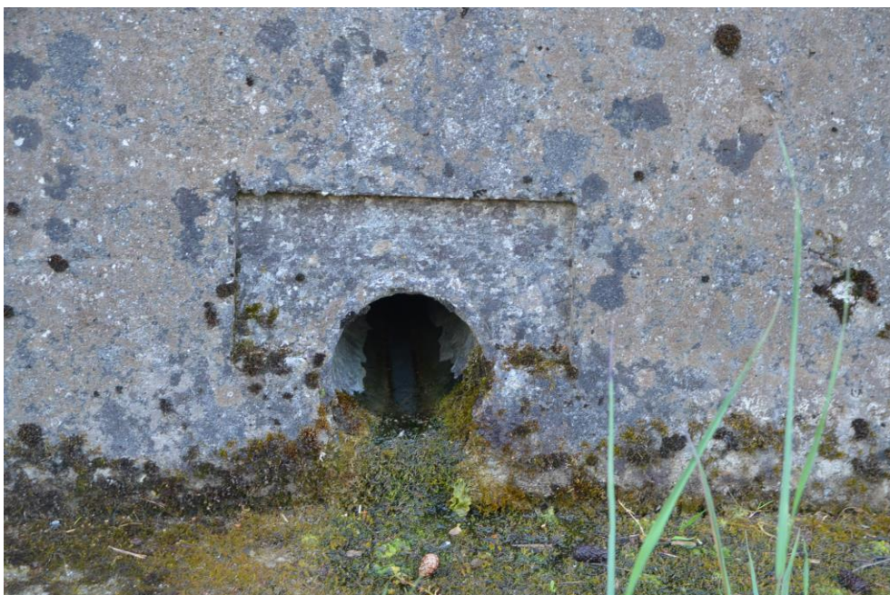
Obr.G99-55 Detail vyústění odvodnění rubu levobřežní zdi skluzu. Pohled zprava doleva,
