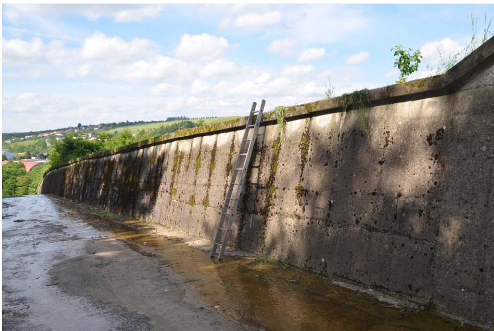
Obr.G99-24 Část pravobřežní zdi skluzu za mostním objektem. Pohled ve směru staničení (po vodě) a zleva doprava, - temeno je opatřeno monolitickou římsou, zábradlí není provedeno!
