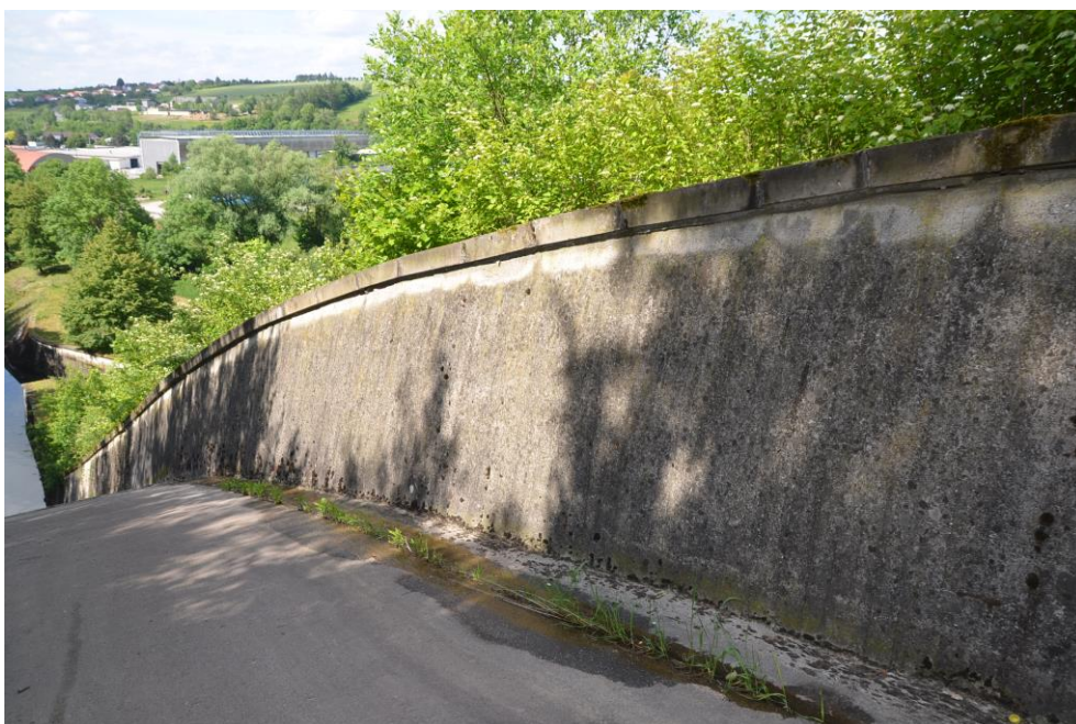
Obr.G99-28 Část pravobřežní zdi skluzu za změnou podélného sklonu dna. Pohled ve směru staničení (po vodě) a zleva doprava,
