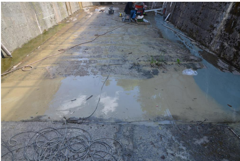
Obr.G99-31 Dno spadiště. Pohled přibližně od konce přelivné hrany, přibližně proti směru staničení (proti vodě), - v popředí výraznější nerovnost (prohlubeň).
