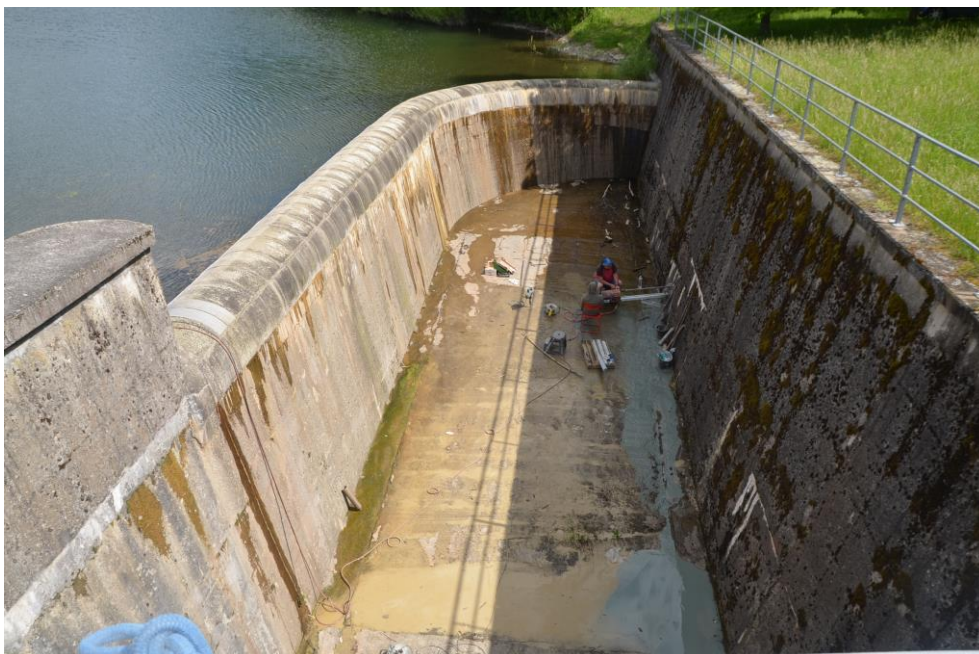
Obr.G99-02 Pohled na bezpečnostní přeliv a spadiště VD. Pohled z mostní konstrukce za koncem sypané zemní hráze, proti směru staničení (proti vodě) a dolů,
