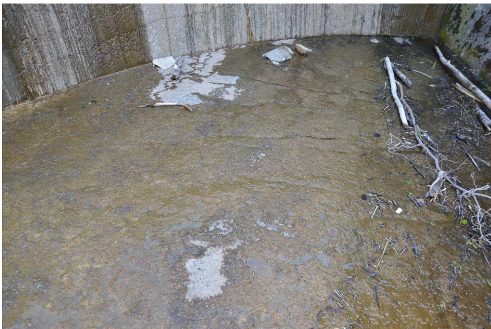
Obr.G99-29 Dno spadiště za místem styku levobřežní zdi a pravobřežní zdi s přelivnou hranou. Pohled přibližně proti směru staničení (proti vodě),
