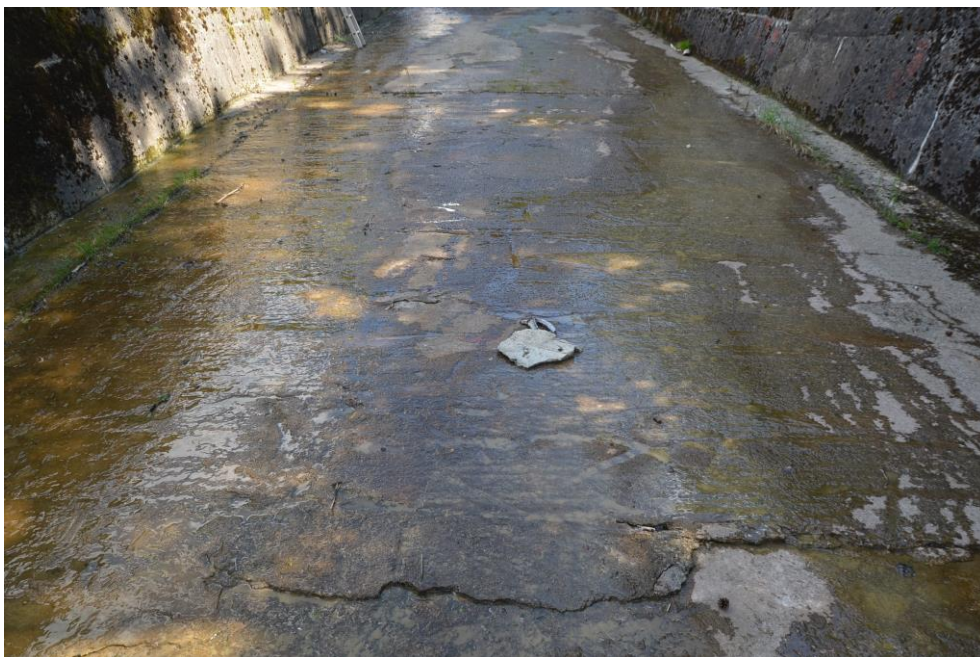
Obr.G99-39 Dno skluzu před změnou podélného sklonu. Pohled přibližně proti směru staničení a dolů (proti vodě), - dno je nerovné, nepřesná betonáž.
