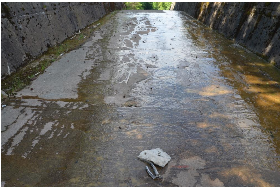
Obr.G99-40 Dno skluzu před změnou podélného sklonu. Pohled přibližně ve směru staničení a dolů (po vodě), - dno je nerovné, na levé straně růst vegetace v podélné pracovní spáře.
