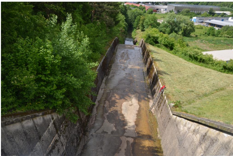
Obr.G99-03 Pohled na část skluzu navazující na bezpečnostní přeliv a spadiště. Pohled z mostní konstrukce za koncem sypané zemní hráze, ve směru staničení (po vodě) a dolů, - vlevo levobřežní zeď skluzu, vpravo pravobřežní zeď skluzu.
