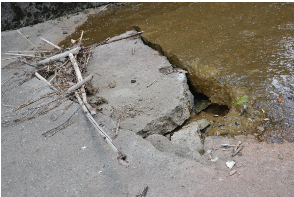
Obr.G99-43 Detail poruchy dna skluzu v místě změny podélného sklonu. Pohled zleva doprava, proti směru staničení (proti vodě) a dolů,
