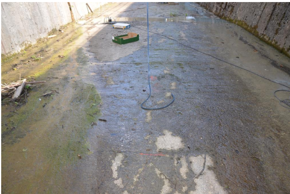
Obr.G99-33 Dno skluzu. Pohled přibližně od konce přelivné hrany, přibližně proti směru staničení a dolů (proti vodě), - v popředí výraznější nerovnost (prohlubeň).
