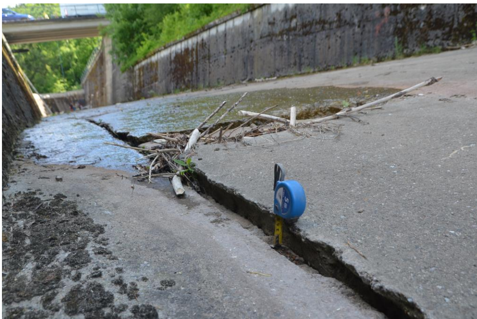
Obr.G99-44 Detail poruchy dna skluzu v místě změny podélného sklonu. Pohled přibližně proti směru staničení (proti vodě) a zprava doleva,
