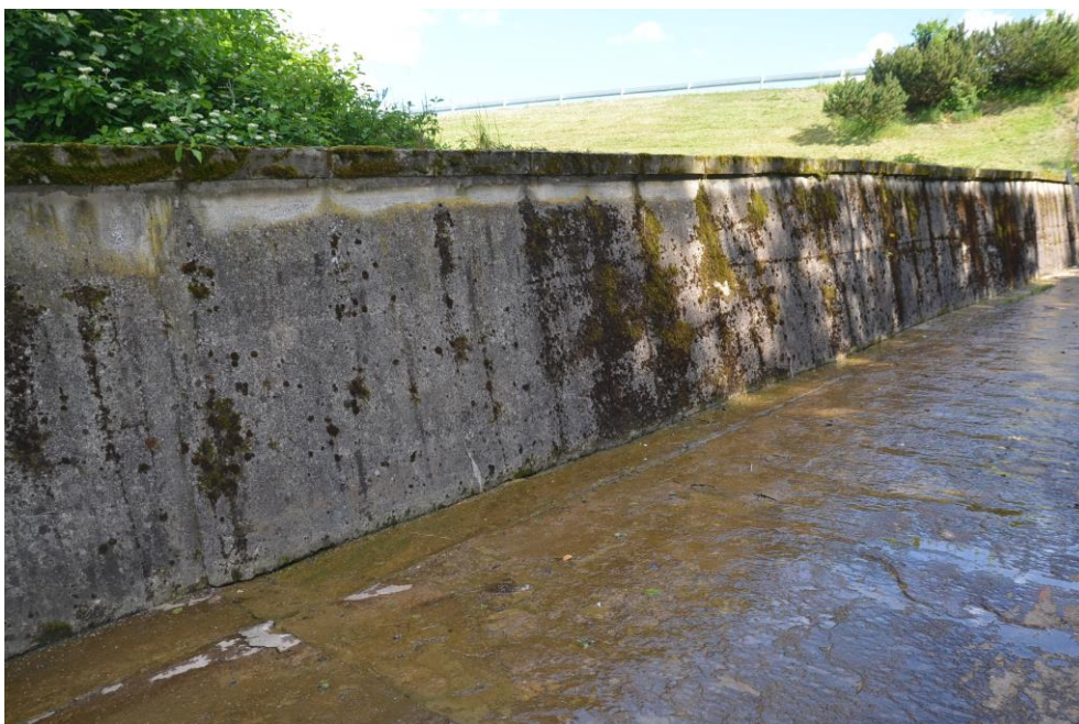
Obr.G99-25 Část pravobřežní zdi skluzu za mostním objektem. Pohled zleva doprava a proti směru staničení (proti vodě), - temeno je opatřeno monolitickou římsou, zábradlí není provedeno!
