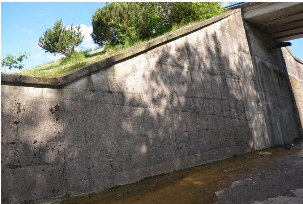
Obr.G99-23 Část pravobřežní zdi skluzu za mostním objektem. Pohled zprava doleva a proti směru staničení (proti vodě), - temeno je opatřeno monolitickou římsou, zábradlí není provedeno!
