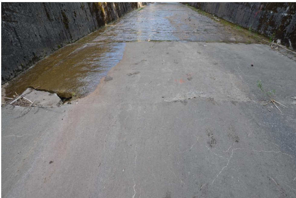
Obr.G99-41 Dno skluzu v místě změny podélného sklonu. Pohled přibližně proti směru staničení a dolů (proti vodě), - dno je nerovné, vpravo (na obr. vlevo) významná porucha dna.
