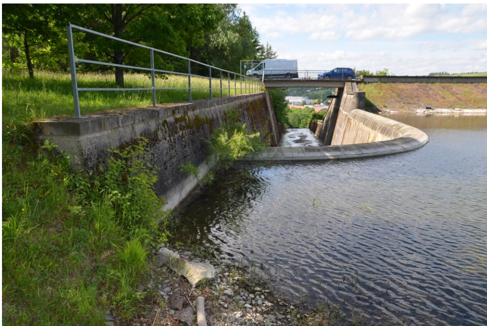
Obr.G99-01 Celkový pohled na bezpečnostní přeliv, spadiště a část skluzu VD. Pohled ve směru staničení (po vodě),
