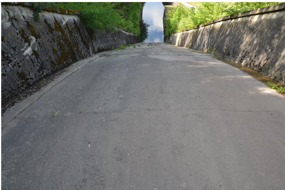
Obr.G99-42 Skluz za místem změny podélného sklonu. Pohled přibližně ve směru staničení a dolů (po vodě), - dno je nerovné, na obou stranách růst vegetace v podélných pracovních spárách.
