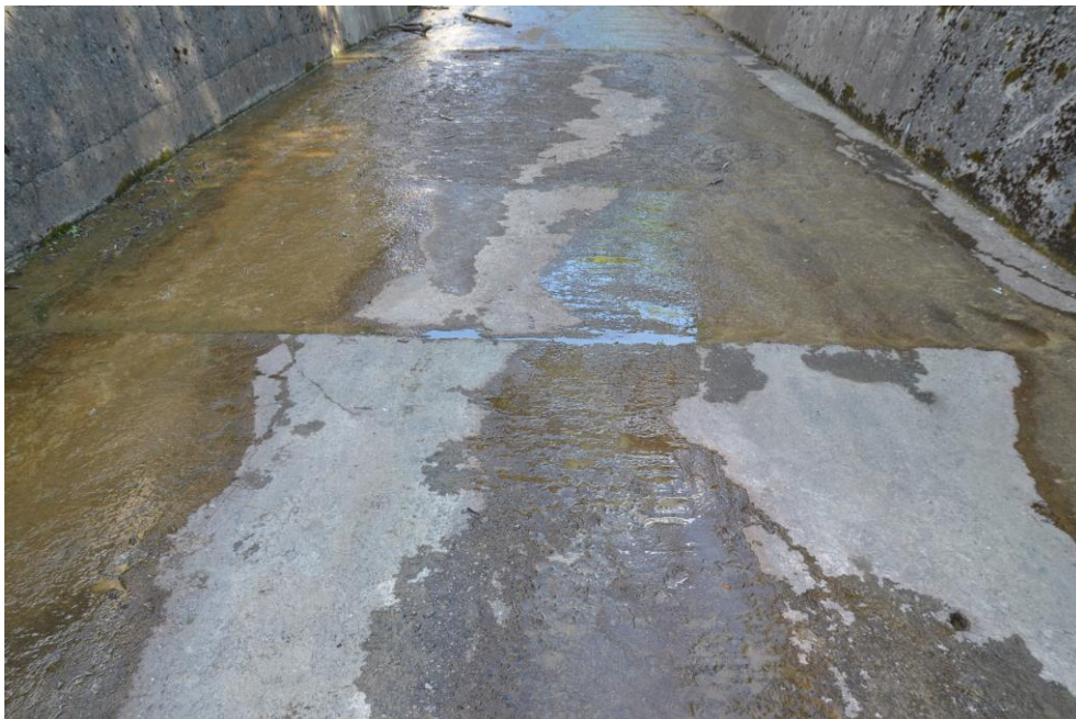
Obr.G99-37 Dno skluzu za křížením s mostním objektem hráze. Pohled přibližně proti směru staničení a dolů (proti vodě), - dno je nerovné, prohlubeň v místě příčné pracovní spáry.
