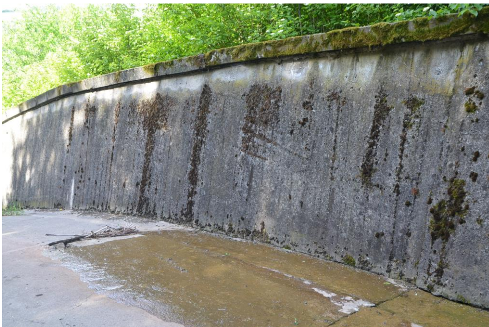
Obr.G99-26 Část pravobřežní zdi skluzu v okolí místa změny podélného sklonu dna. Pohled ve směru staničení (po vodě) a zleva doprava, - temeno je opatřeno monolitickou římsou, zábradlí není provedeno! - významná porucha dna, viz obr. G99-44.
